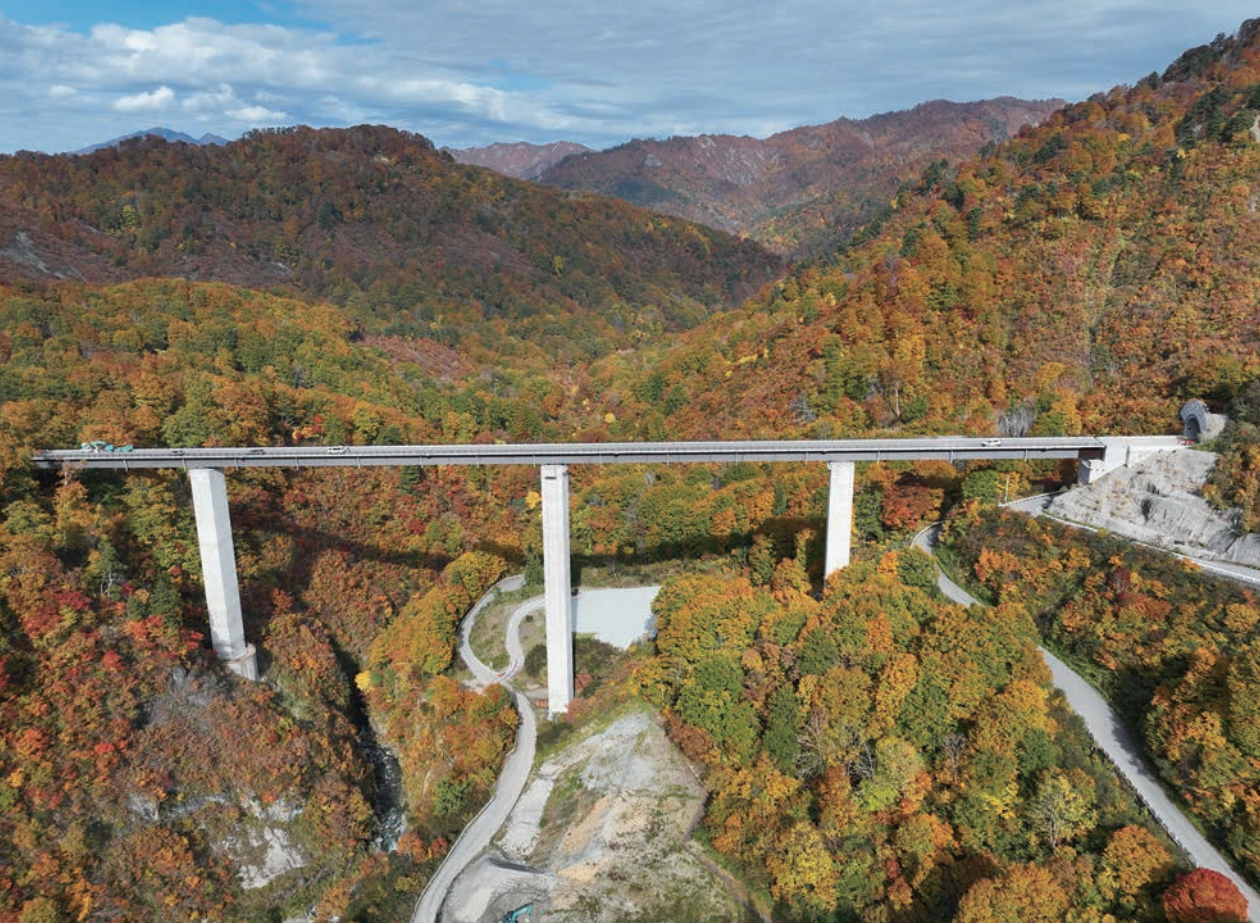
写真提供:長岡国道事務所 八十里越天空大橋
