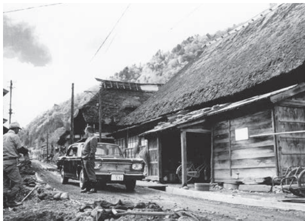
2 S40年道路舗装工事 尾瀬檜枝岐温泉観光協会 S40年道路舗装が始まり、観光村として発展が始まった。
