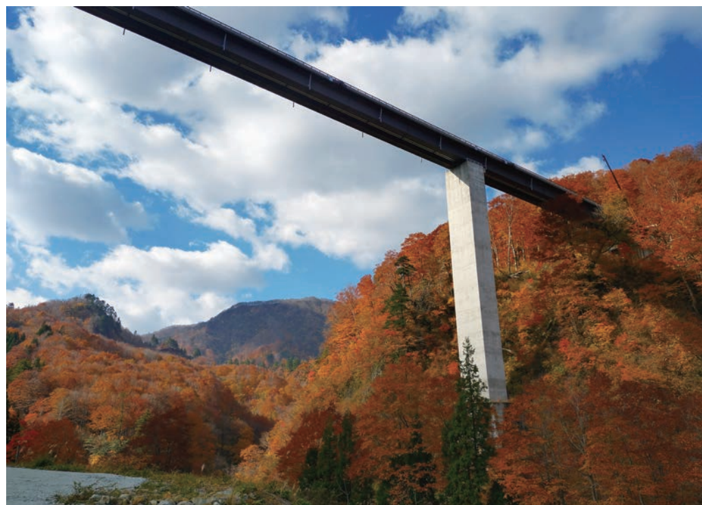
写真提供:長岡国道事務所 八十里越天空大橋
