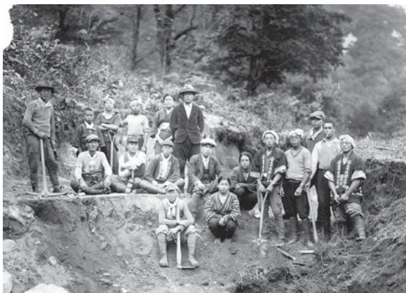
4 道路工事 尾瀬檜枝岐温泉観光協会
