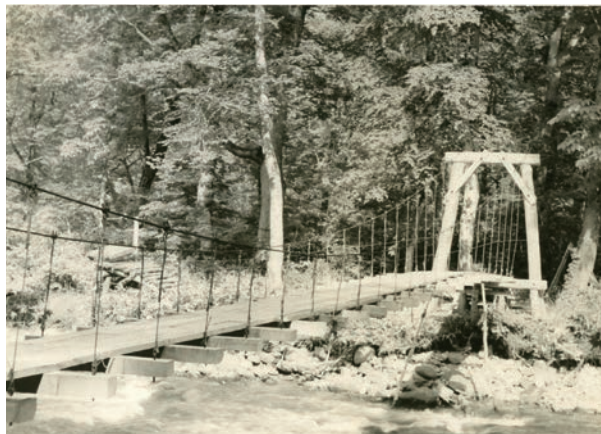
3 只見川 尾瀬檜枝岐温泉観光協会 撮影場所:只見川 福島と新潟を結ぶ第一吊橋(昭28年竣功)この吊橋ができるまでは有名な箆渡しであった。
